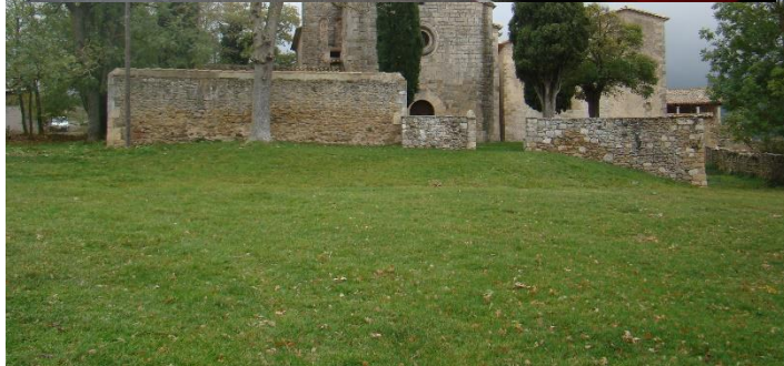
Coniunt de Santa Coloma Saserra
