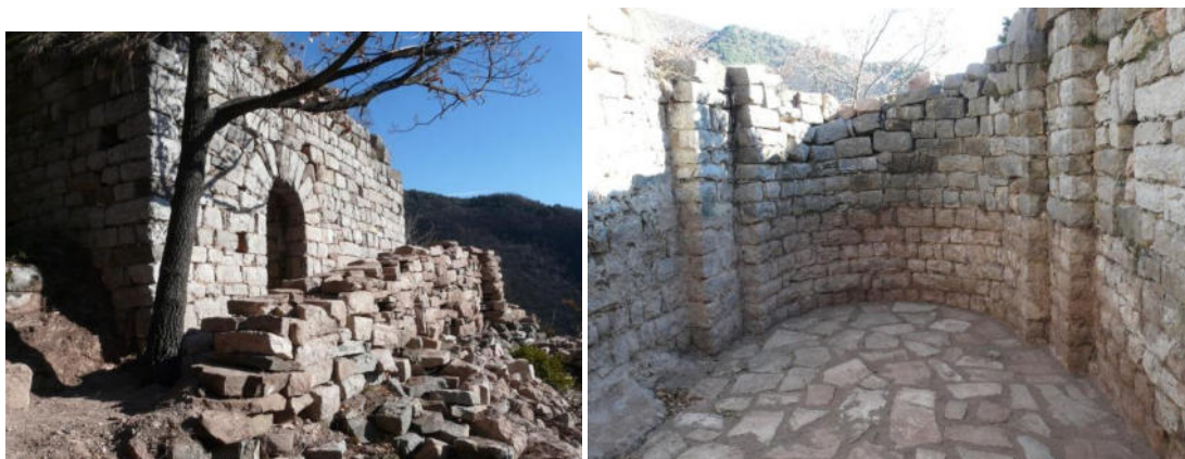
Treballs de consolidació de l'església adequant-ne l'accés i el paviment interior. Foto. Llorenç Pedrals.
