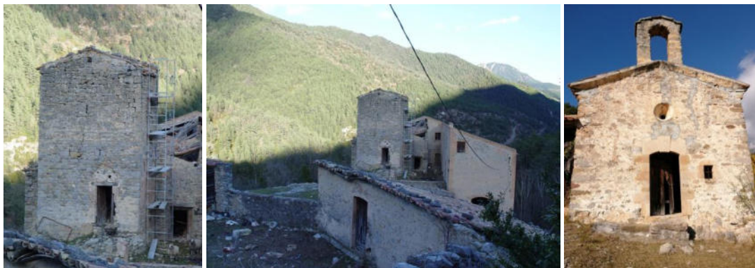
Rehabilitació de la coberta i façana nord de la torre de Faia i façana de Santa Magdalena. Imatges P. Cascante 2006 i 2019.
