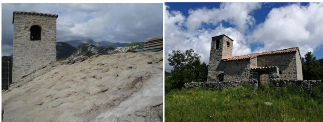
Imatges de la restauració de la coberta (2004) i de l'església en l'actualitat, Imatges arxiu SPAL i Pere Cascante.
