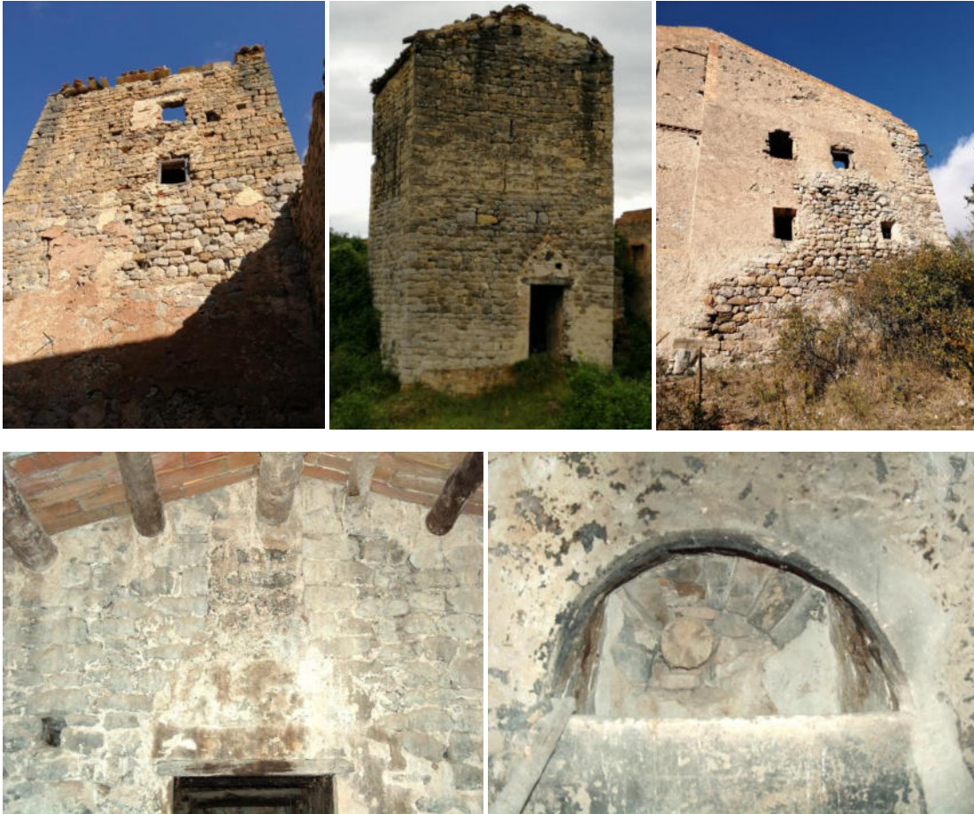
Imatges de la torre des de la banda nord, oest i parament de la sala noble afegida a llevant. A baix detalls de la porta d'entrada a la torra des de la part externa integrada al cos de la sala i a la dreta la part interna amb l'arc de descàrrega. Imatges P. Cascante i Josep Sànchez (interiors)
