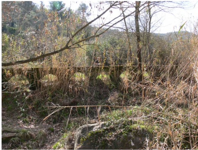
Figura 11: Tram del Rec en què transcorre per un aqüeducte.
