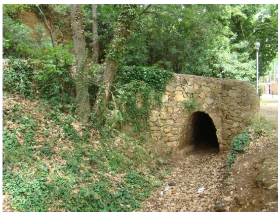
Detall de la volta parabòlica del pont del torrent, al Camí d'en Gaudí.
