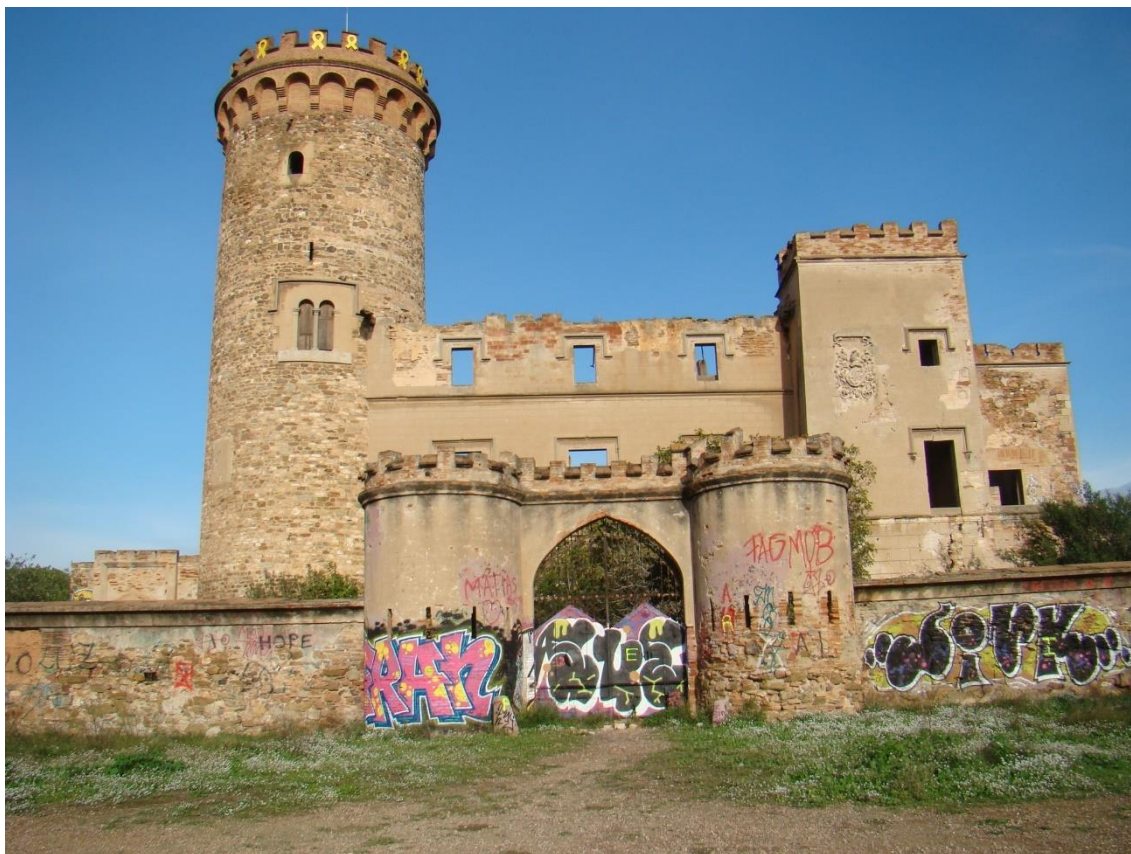
Vista de la bestorre de base quadrada amb l'escut a la façana principal, i de les dues bestorres que delimiten l'interior del recinte.
