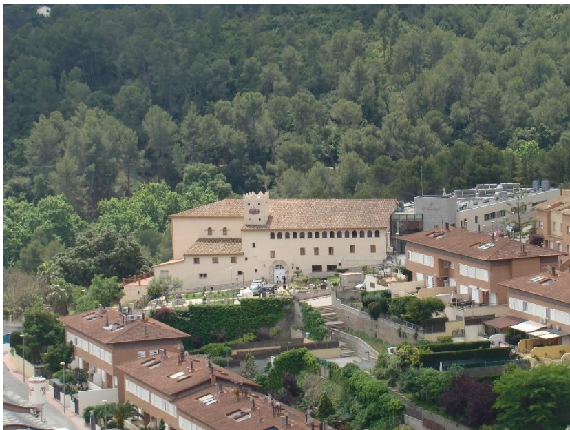
Vista general de Can 63 Via.
