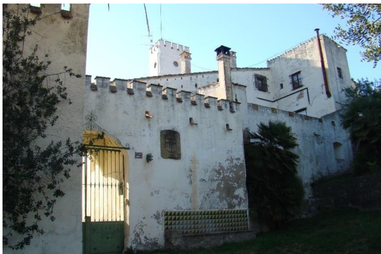
A la imatge superior, vista del cos annex al nord. A la imatge inferior, detall de la façana posterior amb l'escut d'armes.
