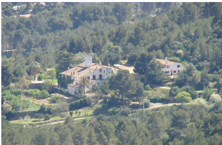
Vista general de Torre Forés
