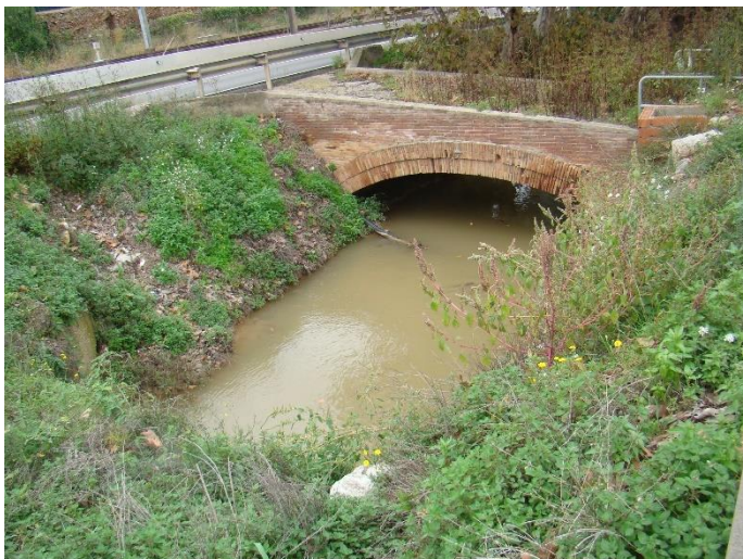
Detall de dos trams del canal de la dreta del Llobregat al seu pas per Santa Coloma. A la imatge inferior es veu un dels ponts que el creua.
