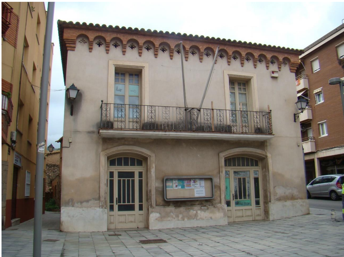
Vista de la façana principal de l'Antic Ajuntament, situat a la confluència entre la Plaça de la Constitució i el Carrer de l'església.
