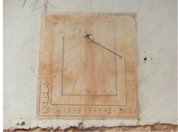
Relotge de sol de can Vacarisses
