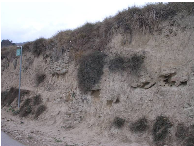
Fig.20. Estructures en un talús camí al Vilar de Múnter.
