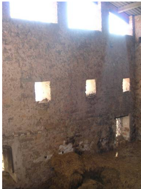
Fig.8. Vista interior de la Pahissa de la Rovira.
