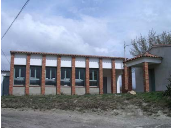
Fig.7. Vista de les escoles velles de Múnter.
