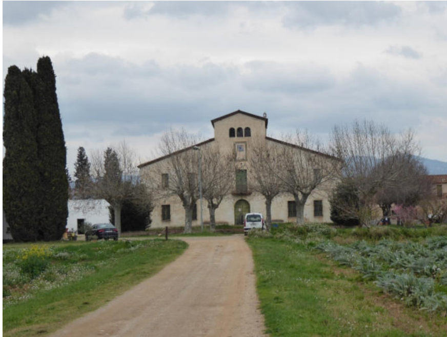
Masia la Bella Plana, construïda en aquest moment com a seu secundària de l'OTA
