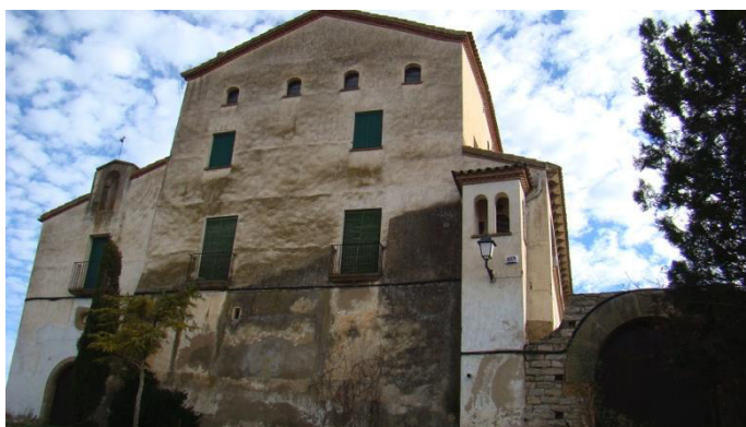
Edifici principal de Cal Bassols.
