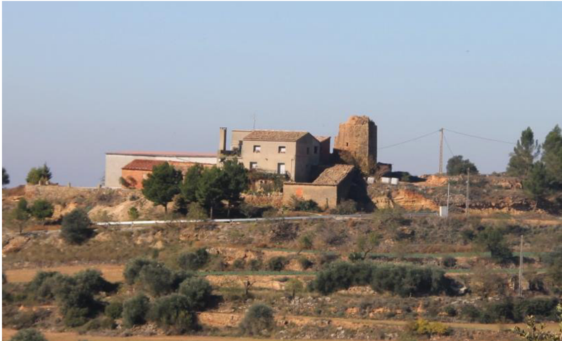
Vista general de Cal Badia.
