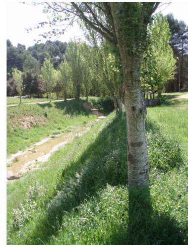
Torrent de Can Campanyà
