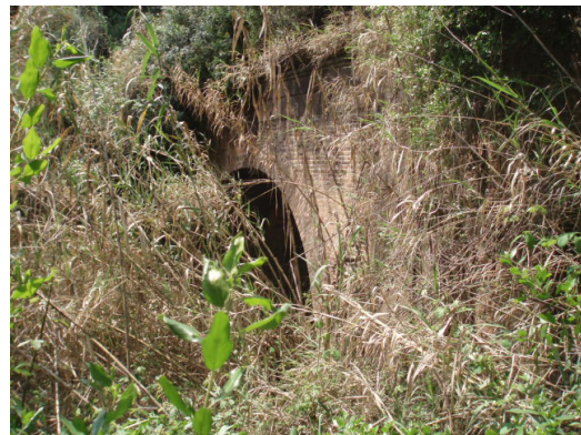
Túnel antic de la Renfe, actualment envaït per la vegetació
