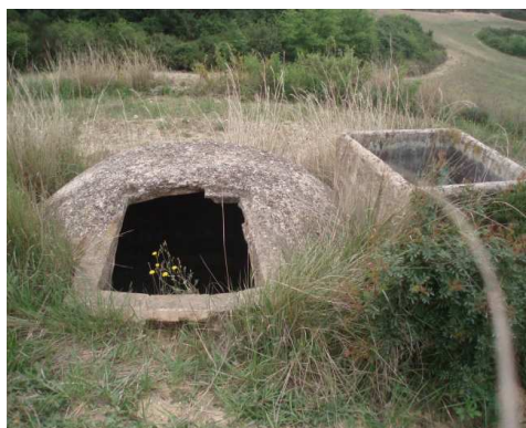
Pou i bassa de la vinya del Capsa, situat al mig del camp. Un dels més ben conservats del terme.
