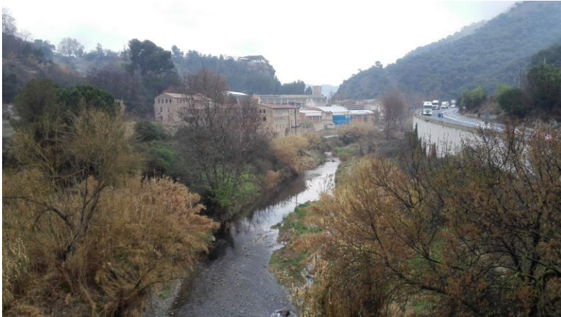
Figura 3. Vista general del riu Anoia, carretera i Cim de Miramar (dreta) i població de Capellades a l'esquerra. En primer terme Can Violant.
