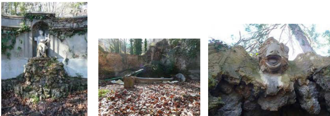
Figures 31-33. Detalls de l'interior de Cal Violant (146) i el seu estat de conservació l'any 2010
