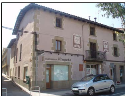
Can Vinyets, casa al casc urbà de Calldetenes
