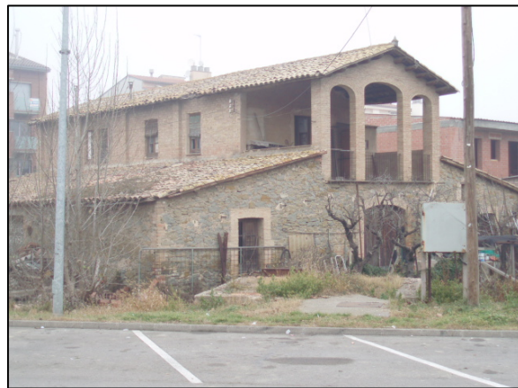
Edifici conegut com l'establiment
