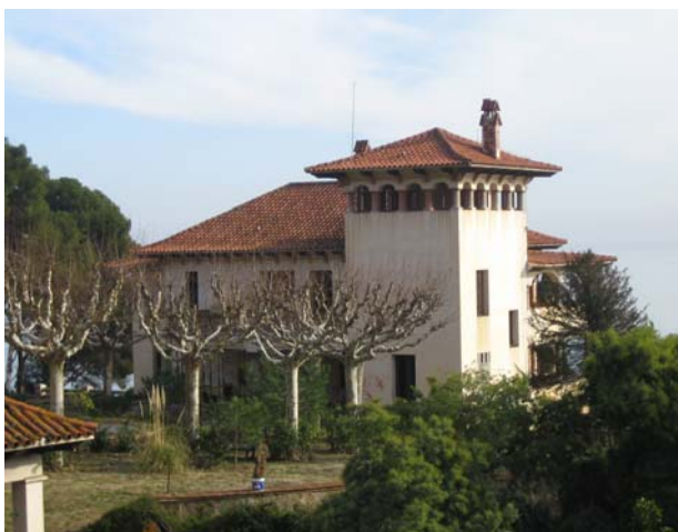
Fig.18. Vista de Can Soler des de la Carretera de Sant Vicenç
