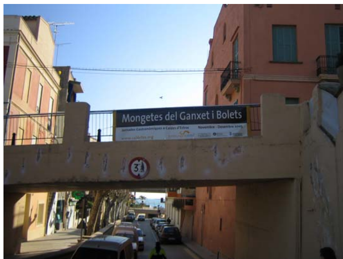
Fig.29. El Pont de Caldes sobre el carrer de la Riera
