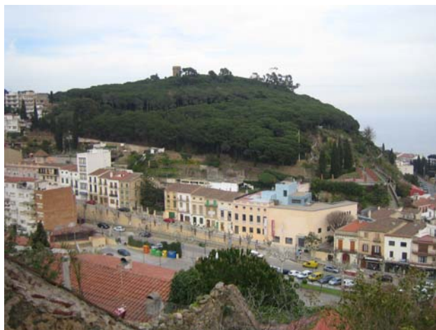
Fig.1. Vista parcial de Caldes d'Estrac
