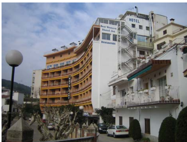
Fig.6. Vista de l'Hotel Jet des del carrer Santema
