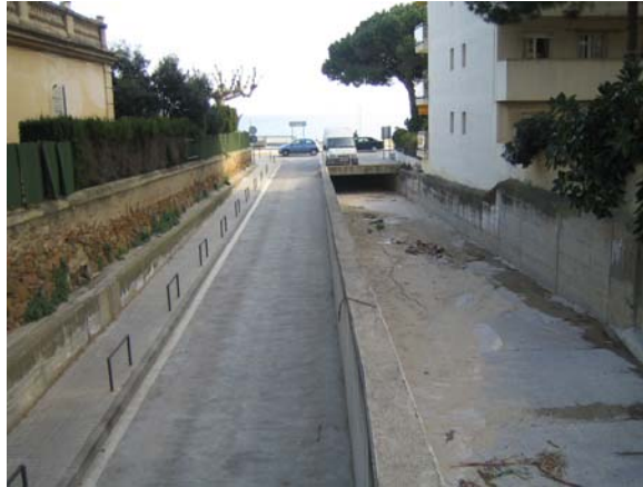
Fig.4. Canalització de la riera del Gorg
