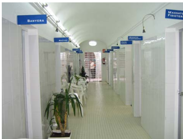
Fig.27. Interior de l'edifici dels Banys Termals
