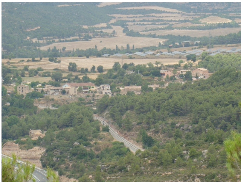
Vista del nucli d'Aguilar, en concret el barri del Raval, des del camí que puja al castell.
