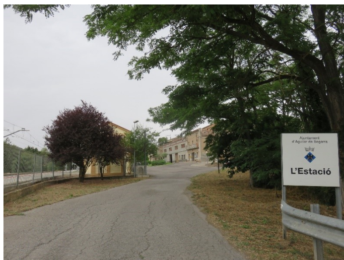
Rètol d'entrada al barri de l'Estació del nucli d'Aguilar de Segarra.
