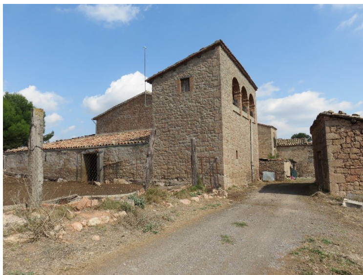
Vista des de l'oest del conjunt d'edificacions del mas de Còdol-rodon
