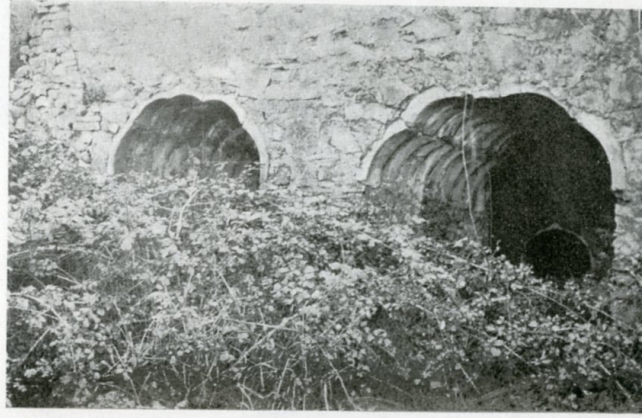
Restos de los antiguos hornos donde se fabricaron los ladrillos para la construcción del primitivo Monasterio
