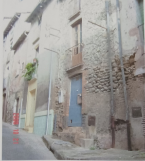
FAÇANA EDIFICI CARRER TORELLÓ NÚM. 11
