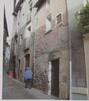
FAÇANA EDIFICI CARRER TORELLÓ NÚM. 7
