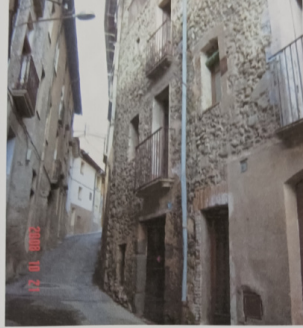
FAÇANA EDIFICI CARRER TORELLÓ NÚM. 3
