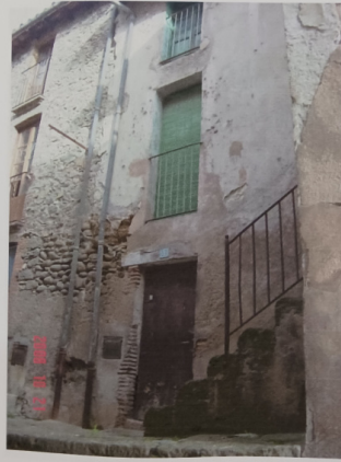
FAÇANA EDIFICI CARRER TORELLÓ NÚM. 13
