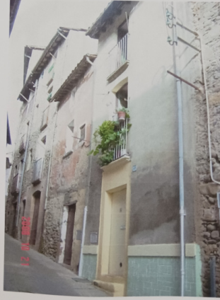
FAÇANA EDIFICI CARRER TORELLÓ NÚM. 9
