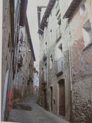
FAÇANA EDIFICI CARRER TORELLÓ NÚM. 5
