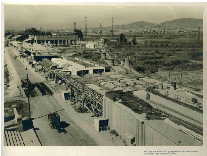
Vista general de las obras y preparación del macanudo del tramo Iudo San Adrián del Botic.
