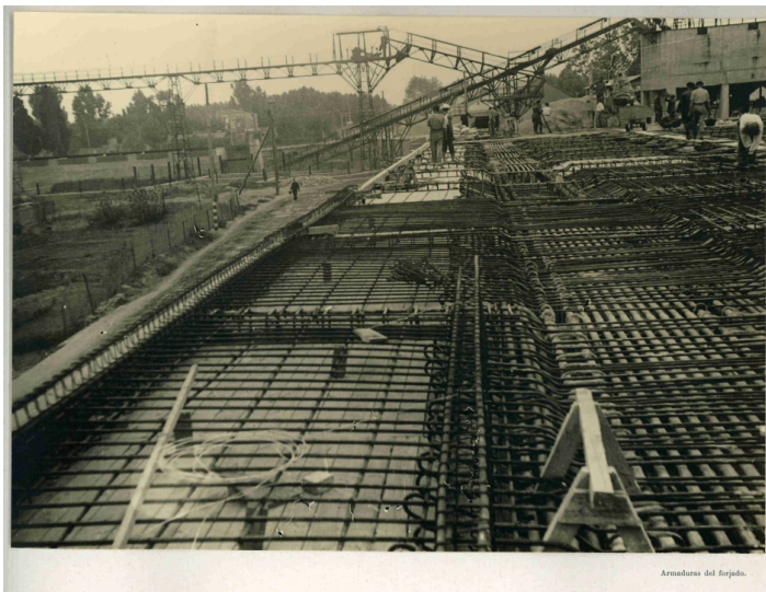
Armadura del forjado.
