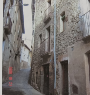
FAÇANA EDIFICI CARRER TORELLÓ NÚM. 3
