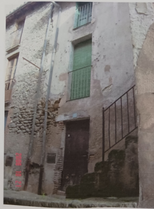
FAÇANA EDIFICI CARRER TORELLÓ NÚM. 13
