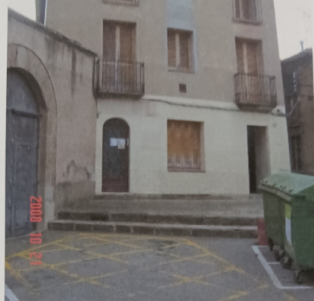
FAÇANA EDIFICI PLAÇA MAJOR NÚM. 8 CANTONADA CARRER TORELLO
