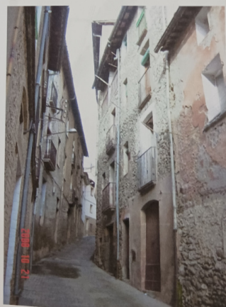
FAÇANA EDIFICI CARRER TORELLÓ NÚM. 5
