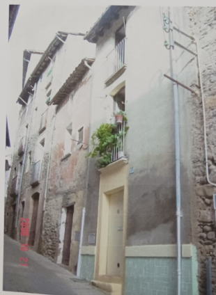
FAÇANA EDIFICI CARRER TORELLÓ NÚM. 9
