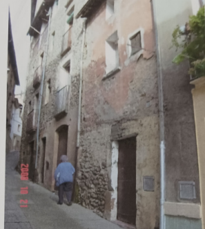
FAÇANA EDIFICI CARRER TORELLÓ NÚM. 7
