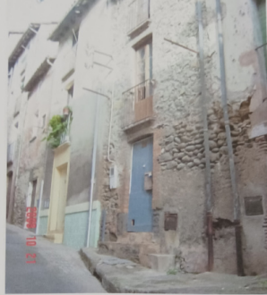
FAÇANA EDIFICI CARRER TORELLÓ NÚM. 11
